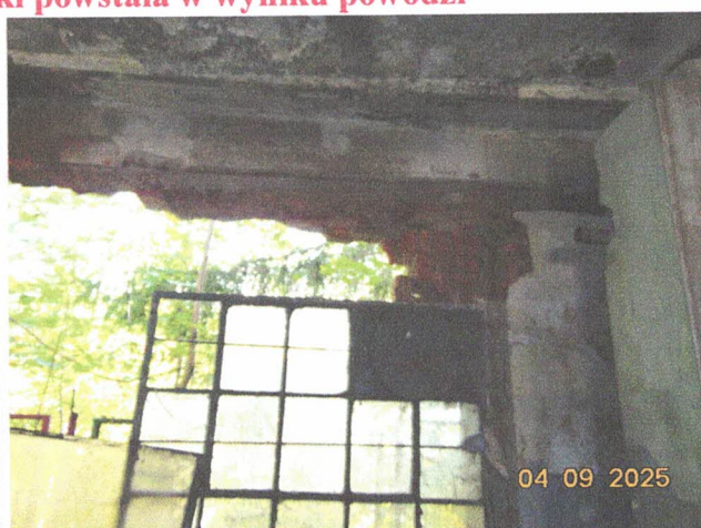
Wyrwa w ścianie tylnej od rzeki powstała w wyniku powodzi
